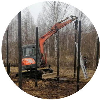
Процесс монтажа винтовой сваи
